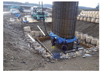
橋梁の耐震補強工事
